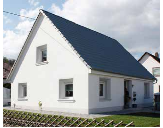
WDVS Arbeiten (Vollwärmeschutz) mit den neuesten Energiestandards
