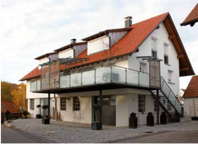
WDVS und Außenputzarbeiten
